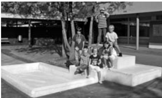
Der Brunnen im Rohbau. Die Schülerinnen und Schüler können die künstlerischen Arbeiten in Angriff nehmen. Dabei werden sie durch Sarina Erhart unterstützt.
