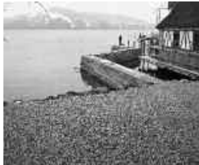
Der neue Platz am See östlich des Bootshauses.
