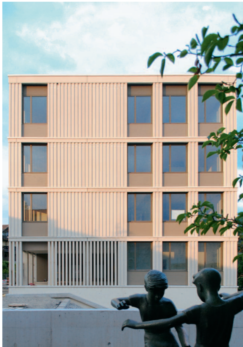
Der Sockel und die Fassade des Neubaus Schulhaus Hofmatt 4 treten markant in Erscheinung und verleihen der Schulanlage ein neues Gesicht. Eingebaut wurden 428 Betonelemente und 116 Fenster.
