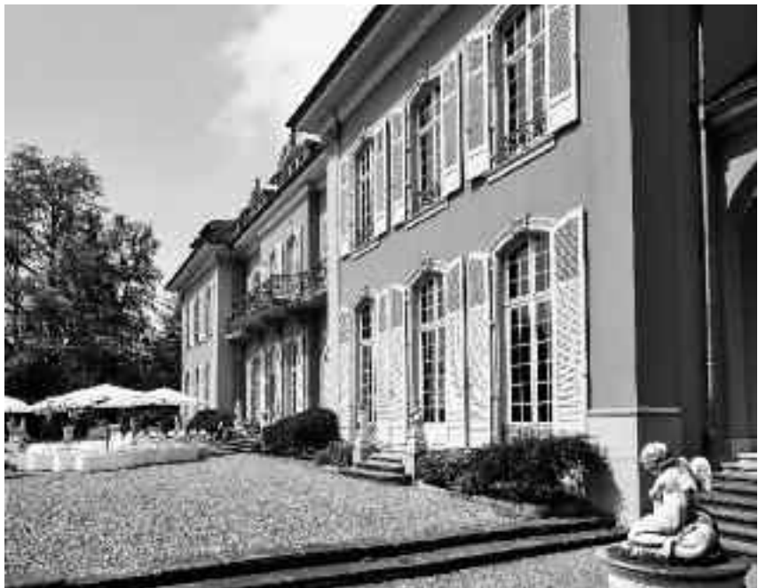
Die idyllisch in Meggen gelegene Villa St. Charles Hall soll für rund vier Millionen Franken umfassend saniert werden.
