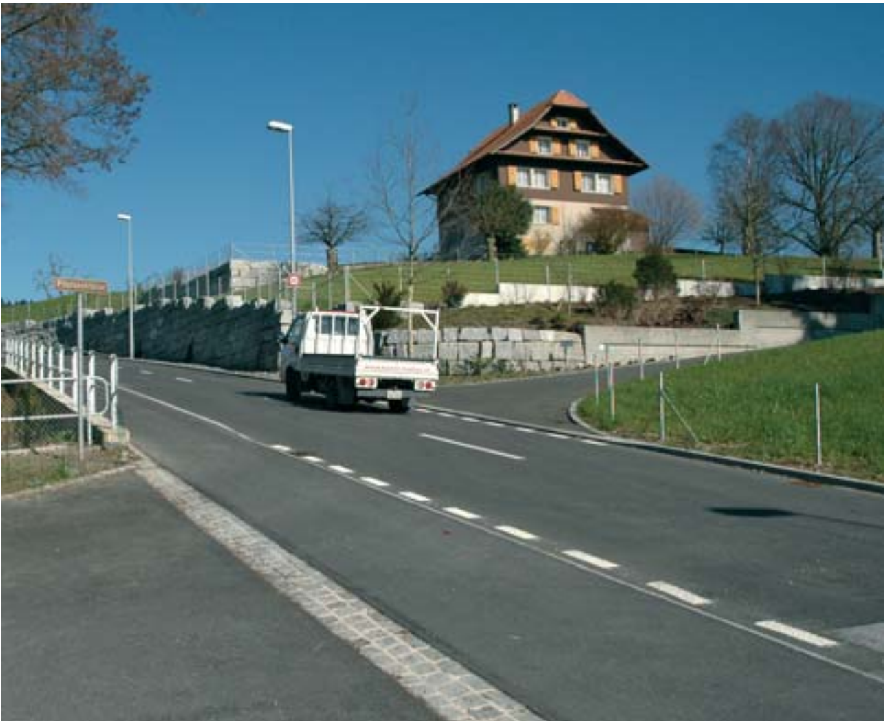
Bei der Sentibühlstrasse wurde zwischen der Obermatt- und Rigistrasse ein Trottoir erstellt.
