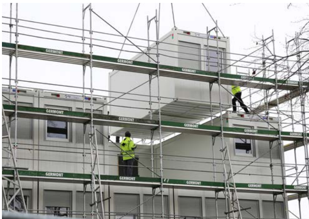
Bilder oben und unten links: Montage der letzten Container am Standort Gottlieben.
