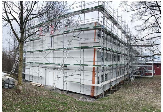
Der Rohbau der Wohncontainersiedlung ist erstellt. Zurzeit laufen die Innenausbauarbeiten.
