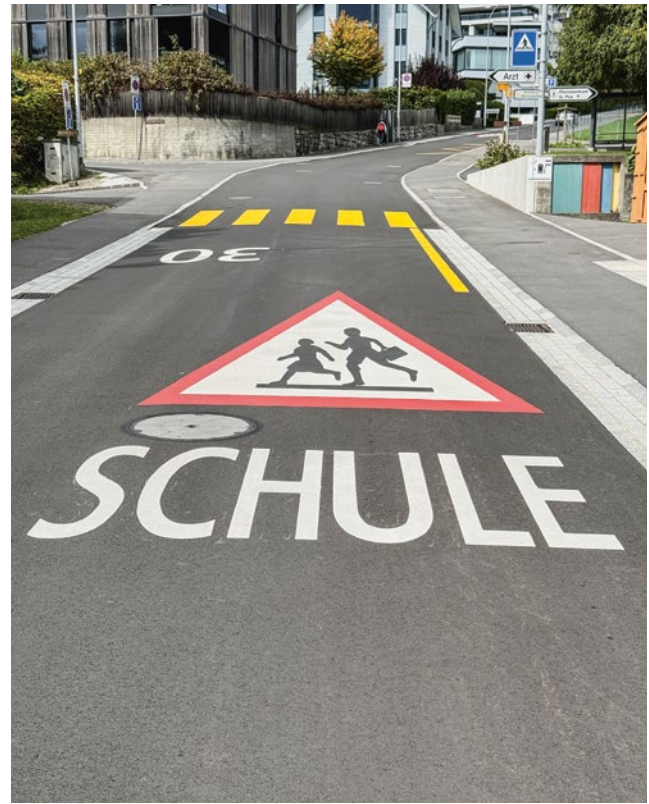
An der Schösslistrasse wurden Wasserleitungen ersetzt und bauliche Massnahmen für Tempo 30 umgesetzt.
