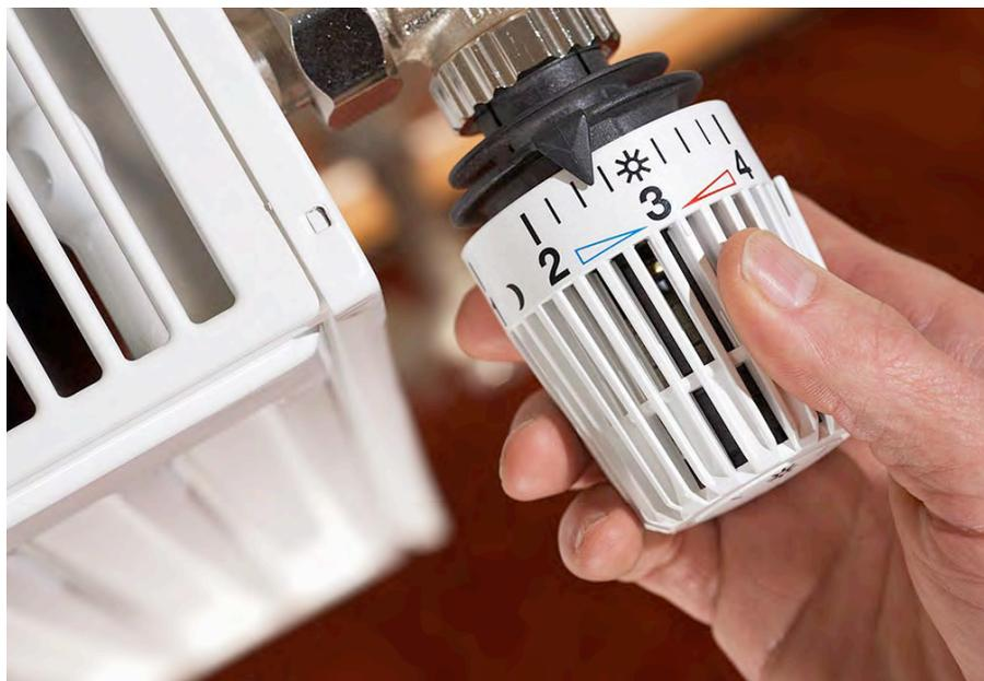
Einstellung der Heizköperventile. Thermostatventile sind dabei am effizientesten. Mit ihnen lässt sich die Wärme bequem in jedem Raum auf demjenigen Niveau halten, bei dem Sie sich am wohlsten fühlen. Übliche Durchschnittswerte für die einzelnen Räume:
