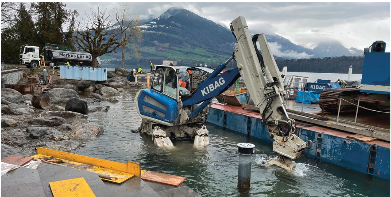
Sanierung Ufermauern beim Fridolin-Hofer-Platz.
