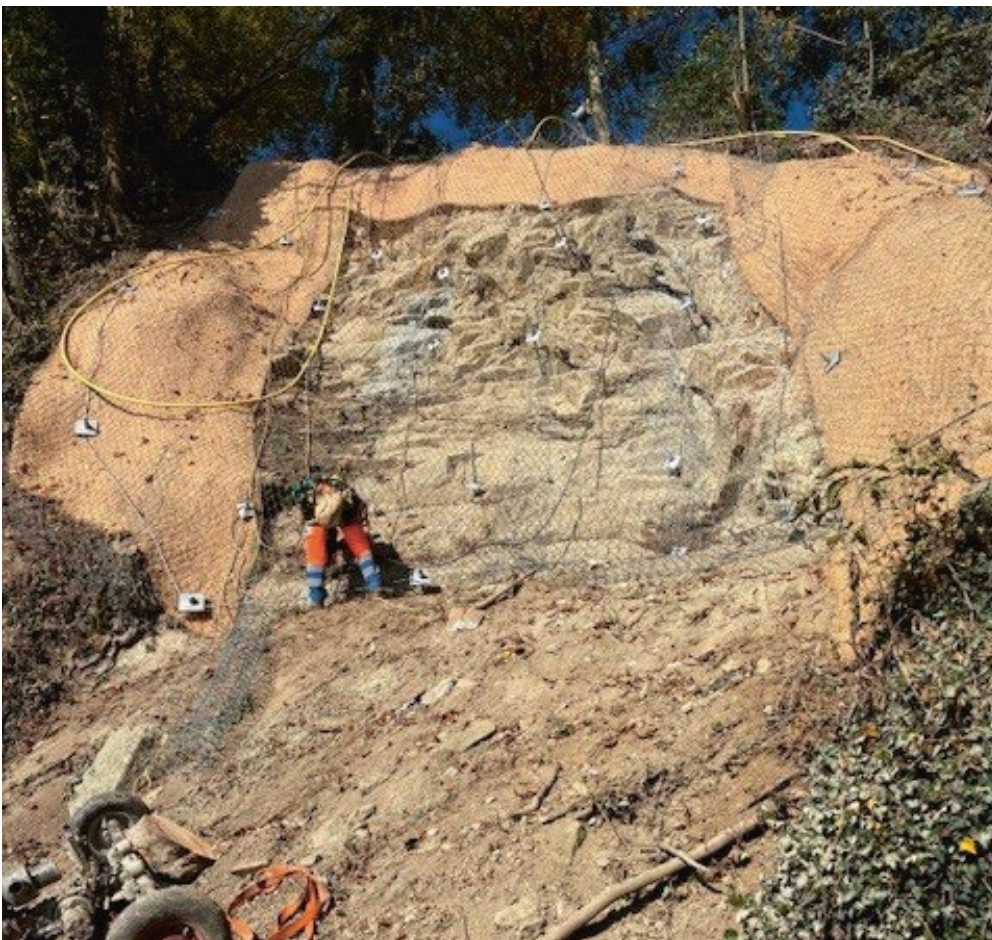
Felssicherungsarbeiten Meggenhorn.
