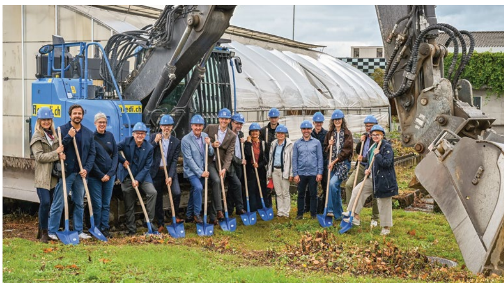
Mit dem Spatenstich fiel offiziell der Startschuss für die Überbauung an der Luzernerstrasse.
