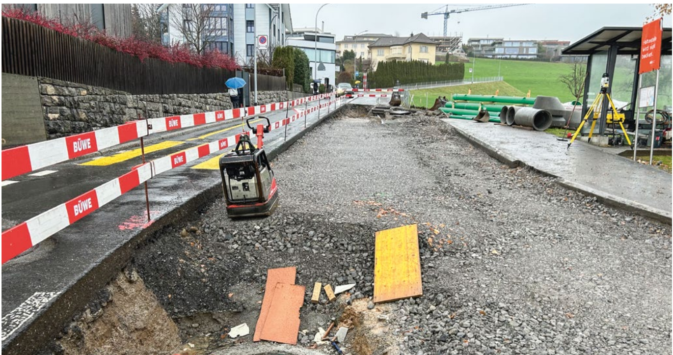
Beim Strassenbau werden Schächte und Leitungen erstellt oder erneuert. So wird die Entwässerungsinfrastruktur laufend unterhalten und an neue Anforderungen angepasst.
