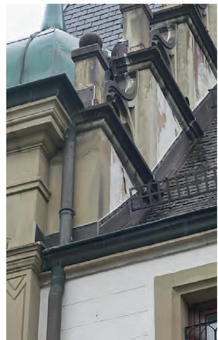
Putzschäden und in der Folge durchnässtes Mauerwerk.
