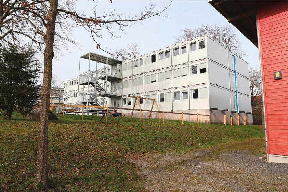
Da stand sie noch: die temporäre Asylcontainersiedlung im Gebiet Gottlieben.
