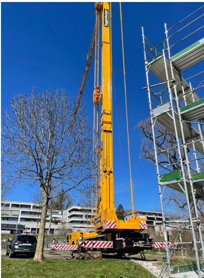
Aufbau der Containersiedlung.
