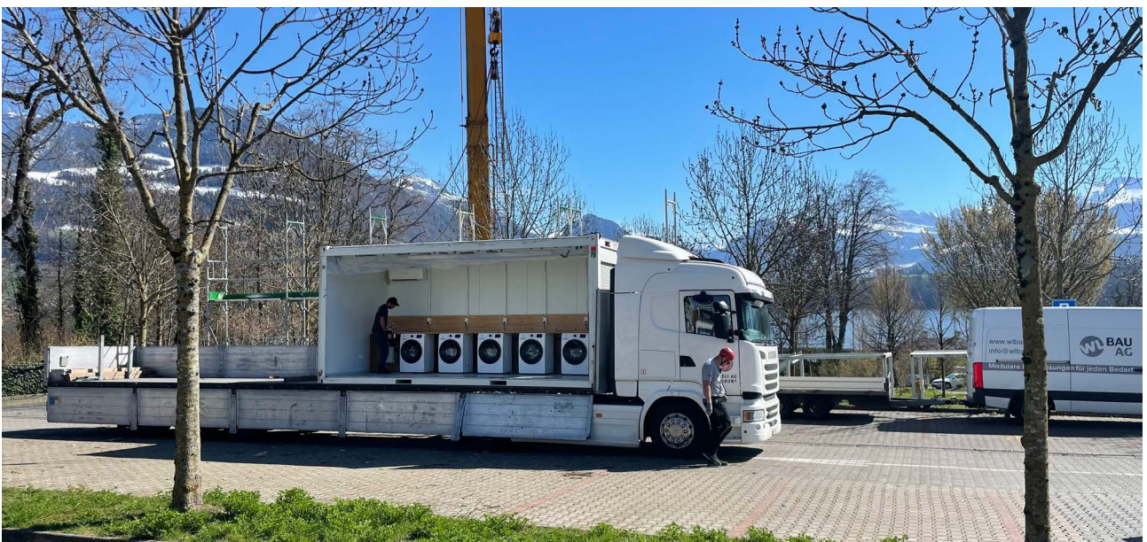
Der Rückbau der Containersiedlung wurde bis Ostern 2026 abgeschlossen.
