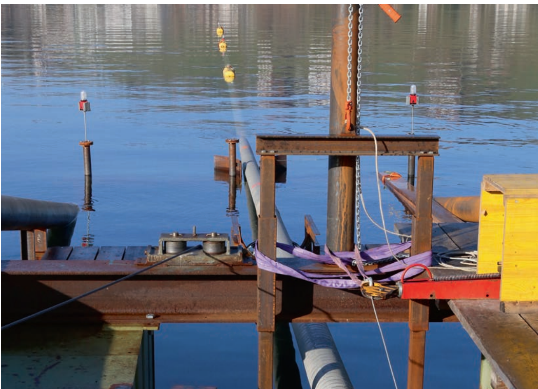
Ein spannendes Projekt der Wasserversorgung Meggen: Die Erneuerung der Transportwasserleitung Lauerz-Meggen beinhaltet im Abschnitt von Arth nach Immensee die Verlegung der Leitung in den Zugersee. Im Bild links die damalige Absenkung der Leitung im Vierwaldstättersee zwischen Küsnacht und Merlischachen.
