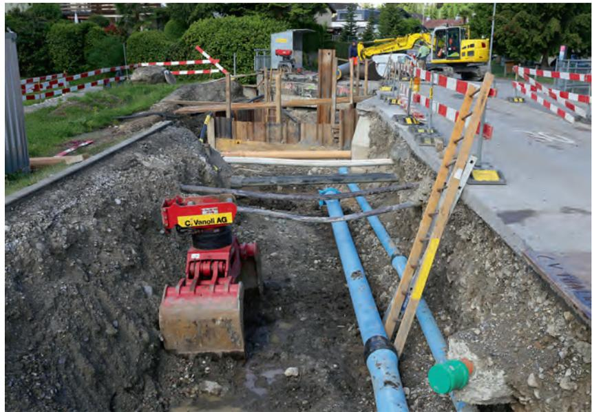
*Die Unterquerung des Giessenbaches in Küssnacht stellte aufgrund der bestehenden Fundationspfähle eine besondere Herausforderung dar.*
