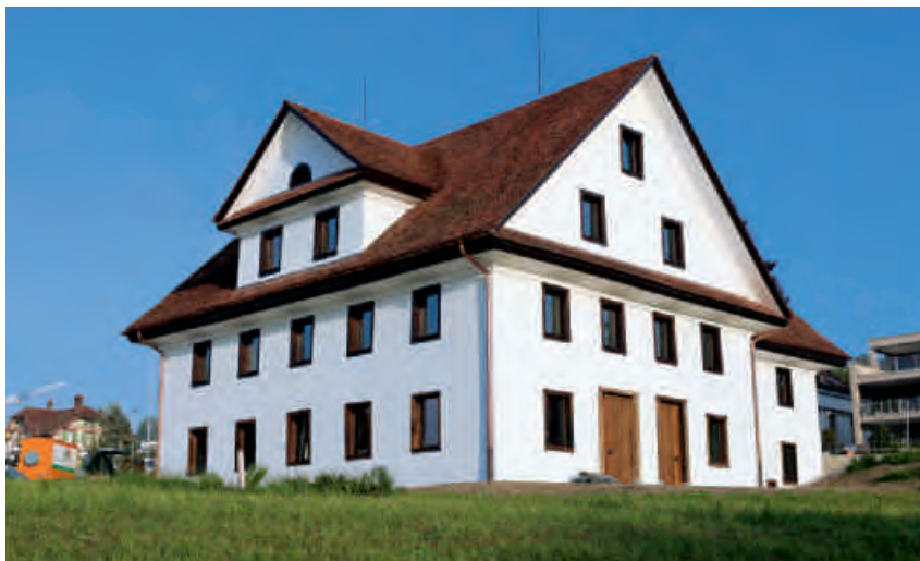
Aussenansicht der sanierten und umgebauten Kreuztrotte.
