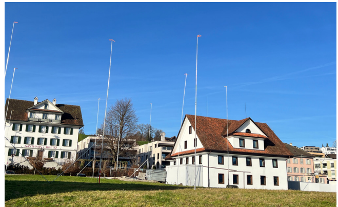
Auf der Kreuzmatte in Meggen stehen weiterhin Profilstangen statt Wohnungen. In der Mitte die seit dem Jahr 2019 renovierte Kreuztrotte.
