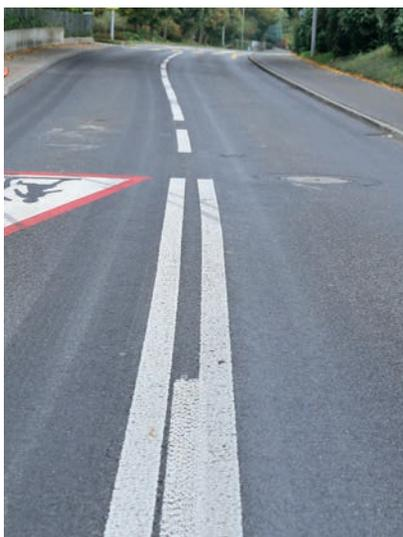
*Sanierung der Adligenswilerstrasse: Auf dem Abschnitt Obermatt bis Tschädigen wird ein lärmarmer Asphaltbelag eingebaut.*
