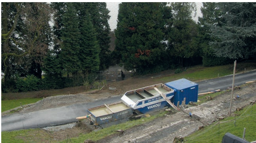
Nach dem Auffangbecken für das Grobmaterial sind gemäss SIA 431 Entwässerung von Baustellen zusätzliche Absetzbecken erforderlich.
