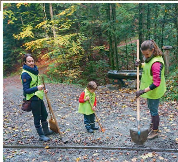
Reinigung einer Rinne.
