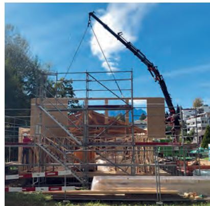
Arbeiten an der Aussenhülle des Pfadiheims.
