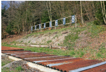
Scheibenstand der Schiessanlage Blossegg.
