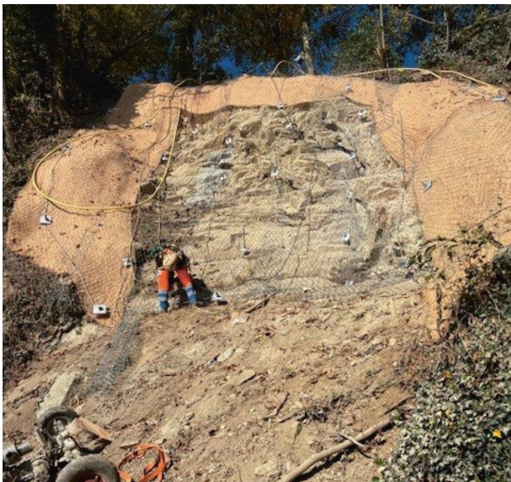
Felssicherungsarbeiten Meggenhorn.
