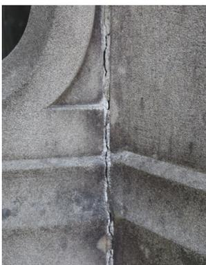
Offene Fugen führen zu Wasserinfiltrationen ins Mauerwerk
