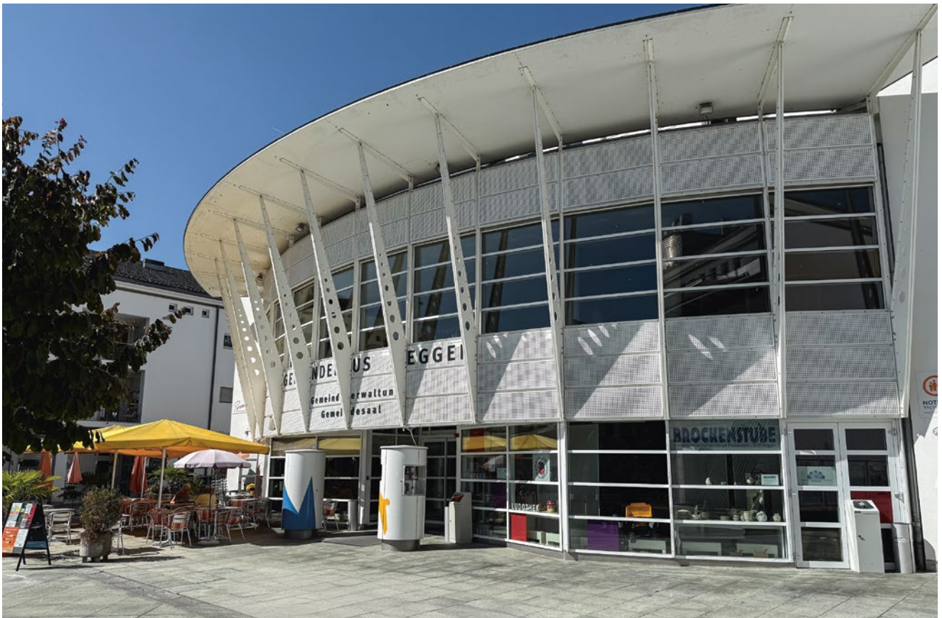
Optimierung der Abläufe in der Gemeindeverwaltung: Im Jahr 2026 soll die Planung für die Sanierung des Gemeindehauses in Angriff genommen werden.
