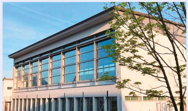
Eine wichtige Investition in die Infrastruktur der Gemeinde Meggen: Ersatz des Hallenbades Hofmatt mit Turnhalle.
