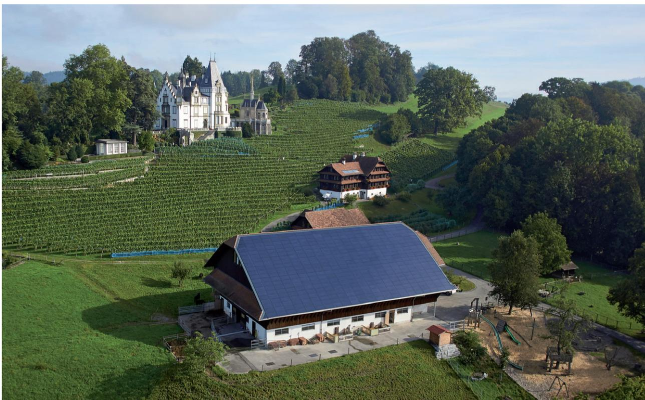
Die Gemeinde Meggen setzt auf erneuerbare Energien. Auf dem Dach der Scheune Meggenhorn wurde im Oktober 2013 eine Photovoltaikanlage in Betrieb genommen. Hochleistungsmodule produzieren auf einer Fläche von 560 m<sup>2</sup> jährlich rund 90 000 kWh Solarstrom.
