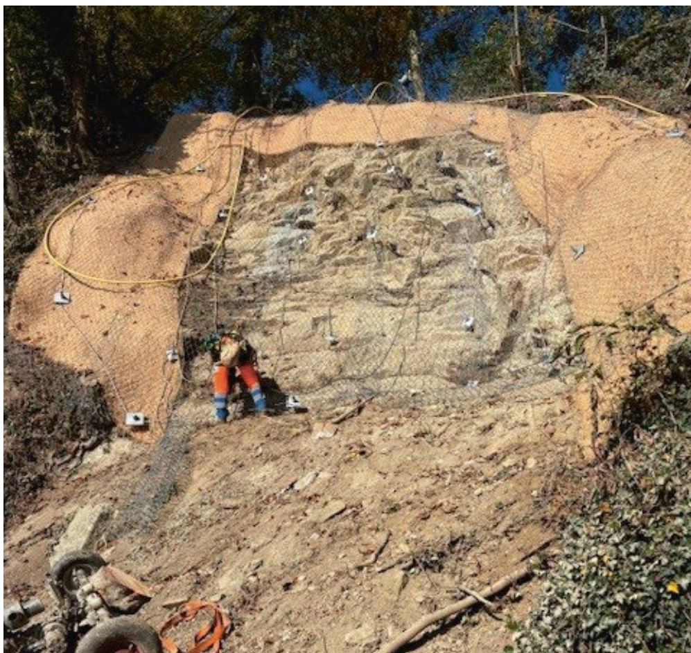
Felssicherungsarbeiten Meggenhorn.
