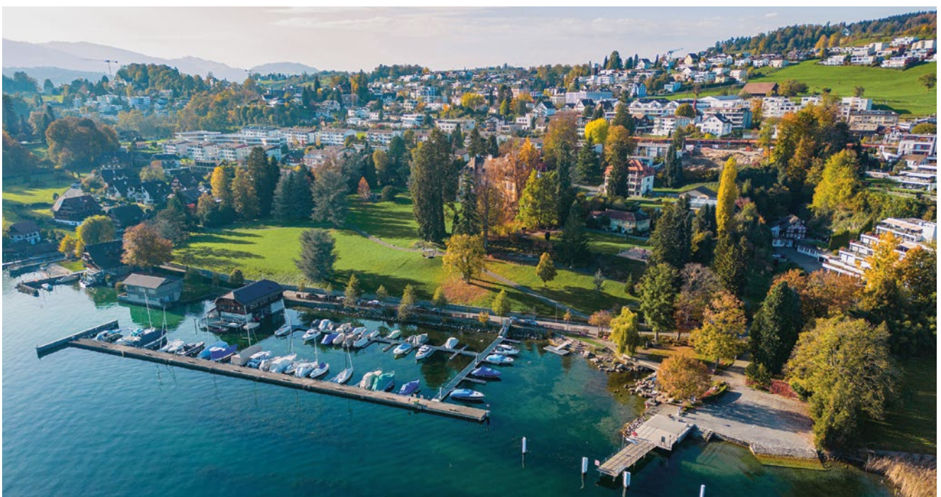
Luftaufnahme Motorbootshafen Meggen.
