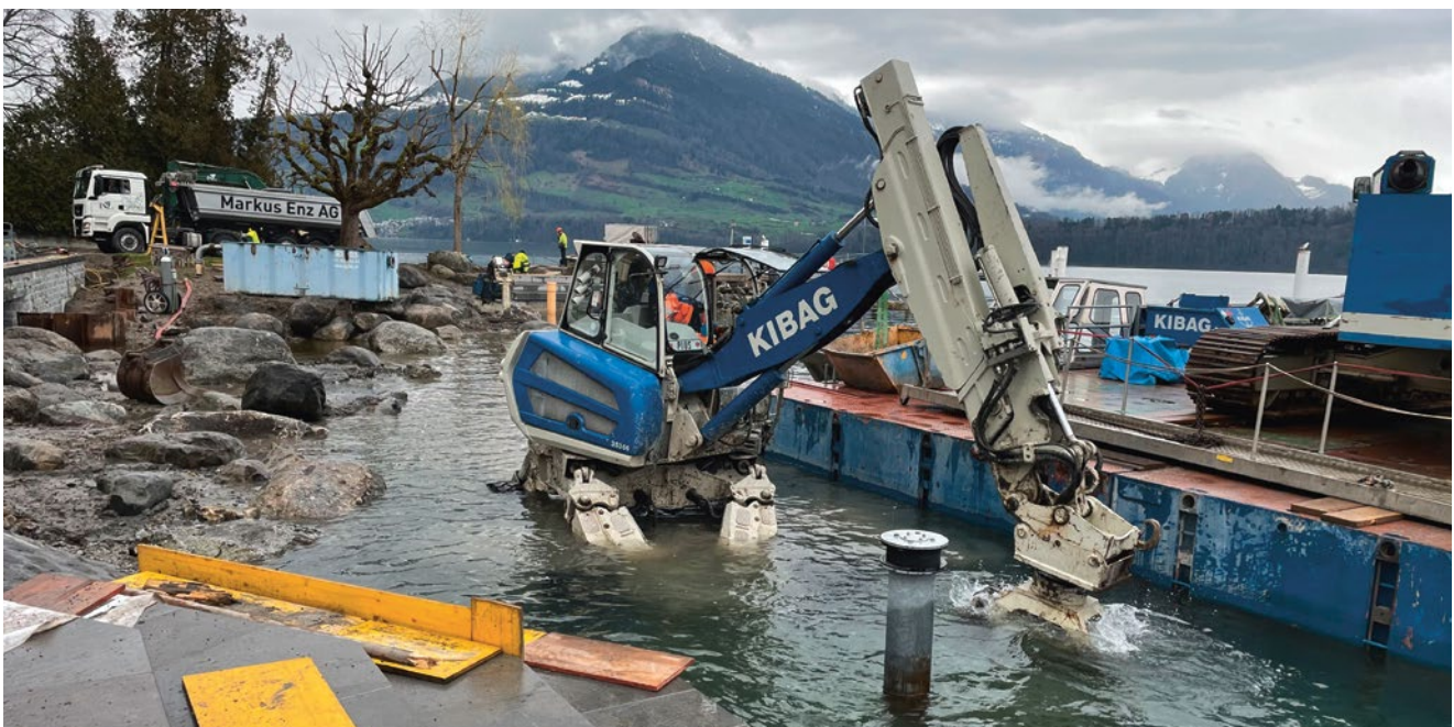
Sanierung Ufermauern beim Fridolin-Hofer-Platz.
